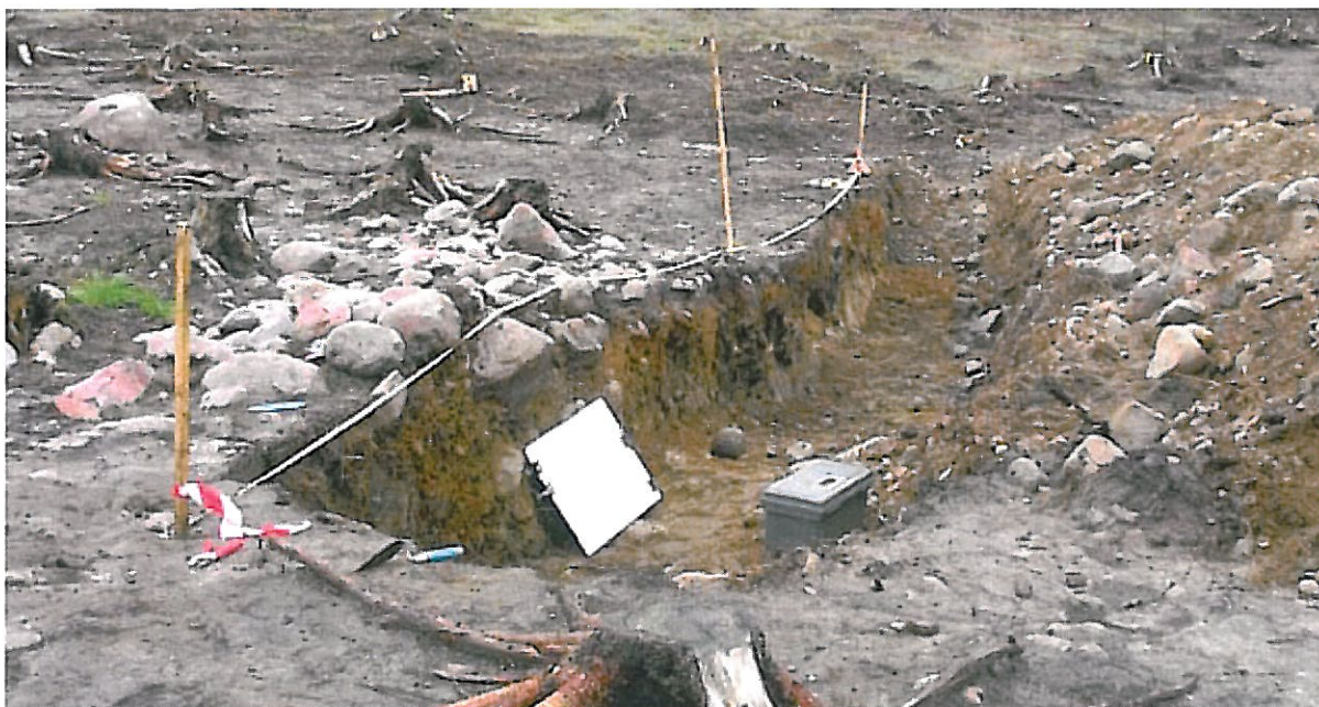
Fig. 13. A811 under arbete. Foto mot nordväst av Anders Karlsson.
